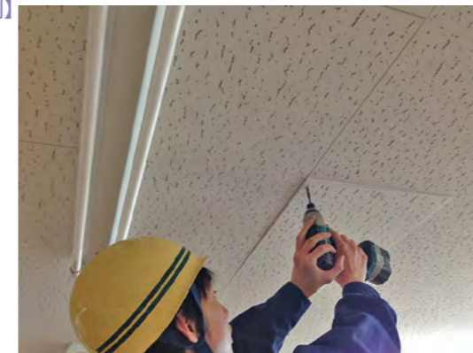
▲化粧ボード留め付け
