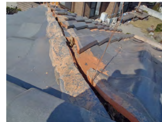
▲がんぶり瓦を撤去
