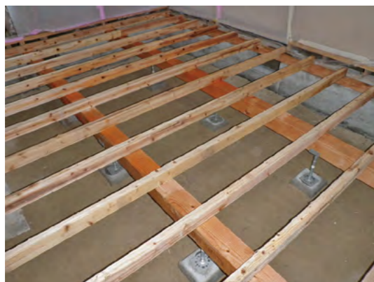
▲土台、根太の点検、交換
