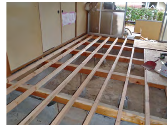
▲土台施工 (床補修と同時に行う場合)
