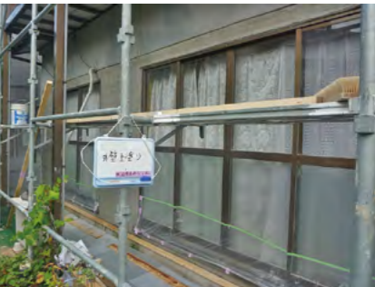
▲モルタル補修完了
