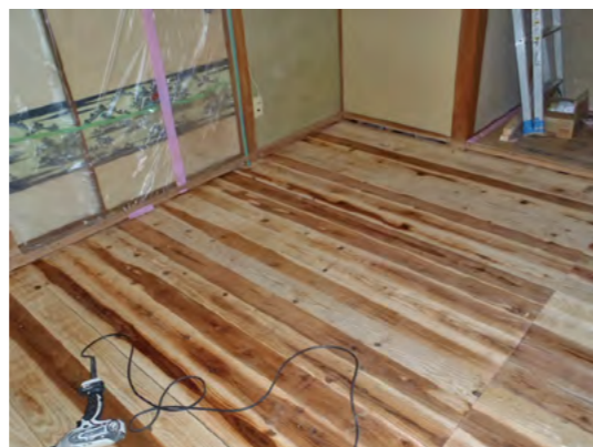
▲下地板張り替え完了
