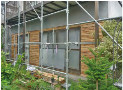
▲下地撤去状況
