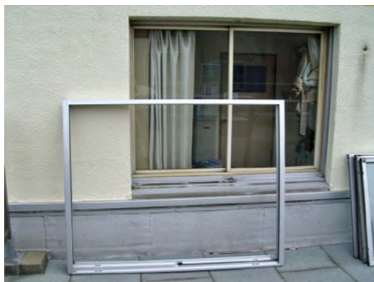
▲カバー工法枠
