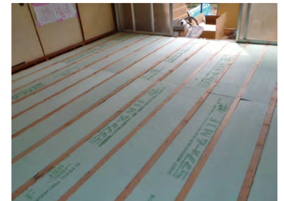
▲ボード状断熱材敷き込み (床補修と同時に行う場合)
