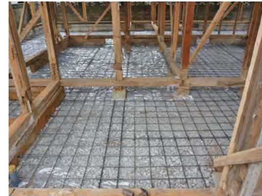
▲ポリフィルム敷きこみ、配筋
