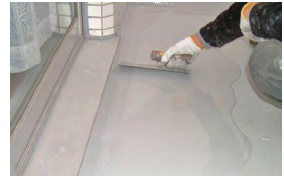
▲ウレタン塗膜防水完了
