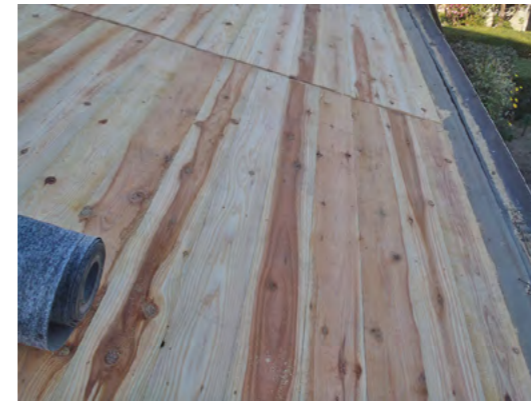
▲野地板の点検、補修
