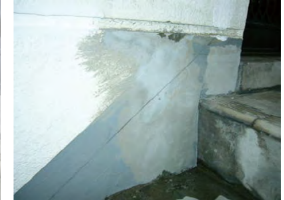
▲樹脂モルタル完了
