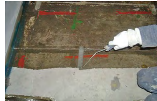
▲プライマー塗布
