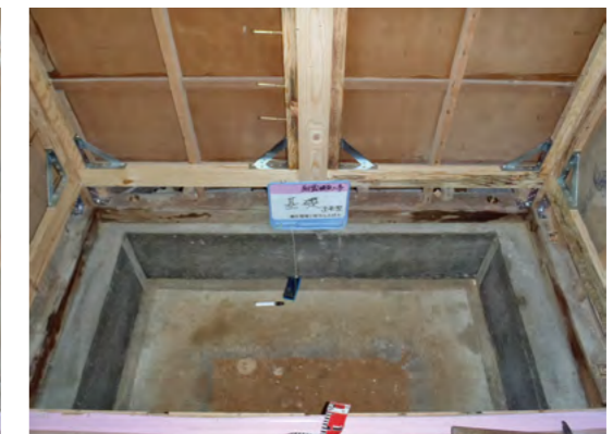
▲増し打ち完了
