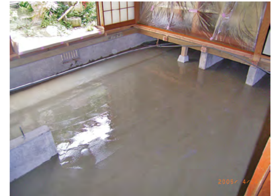
▲コンクリート打設完了
