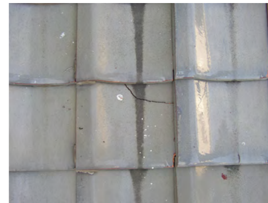
▲破損瓦撤去前
