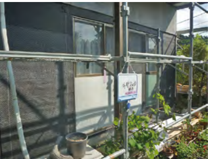
▲下地防水紙、ラスの設置
