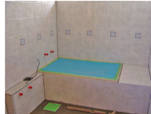
▲床タイル貼り替え状況
