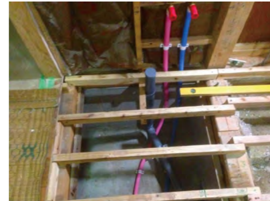
▲配管中 (立上り部)
