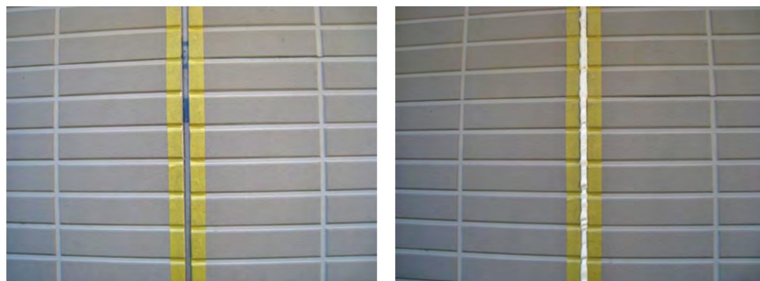
▲シーリング撤去・マスキングテープ
