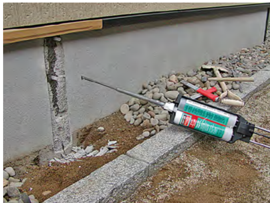
▲ひび割れ部分のモルタル撤去
