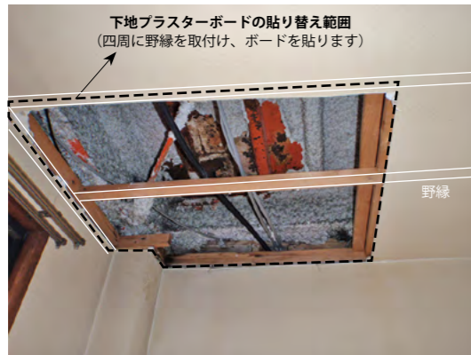
▲傷んだ下地プラスターボードを撤去
