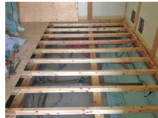
▲クッションフロア及び合板撤去、根太の確認
