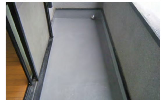
▲FRP 防水工事完了
