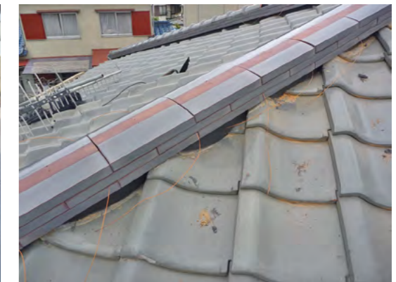
▲棟の取り直し完了
