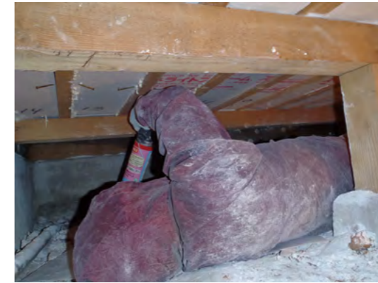
▲ボード状断熱材設置中
