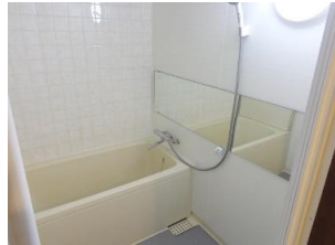
サーモ付き水栓交換 鏡設置！！浴室扉新調！！
