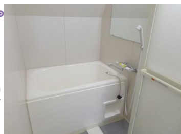
浴室床防水シート上貼！鏡設置！！
