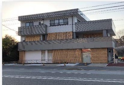
建物正面外観
